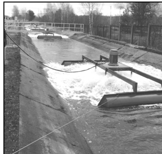
Abb. 7: AEROSTAR-Belüfter im Sammelzubringer West der GWRA Schwarze Pumpe.
