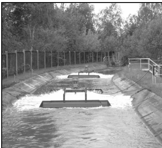
Abb. 7: AEROSTAR-Belüfter im Sammelzubringer West der GWRA Schwarze Pumpe.
